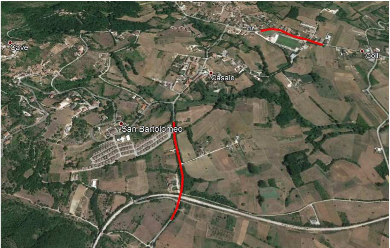
Vista Satellitare S.P. 31 "FORULENSE" Tratto interessato dagli interventi
